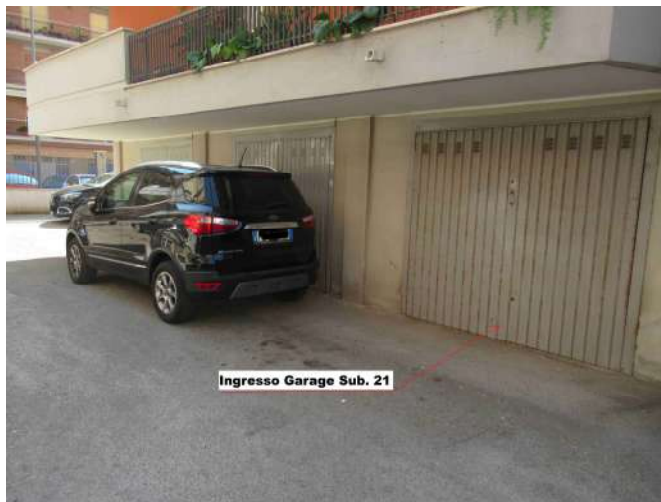
Foto 25 – Ingresso esterno garage
